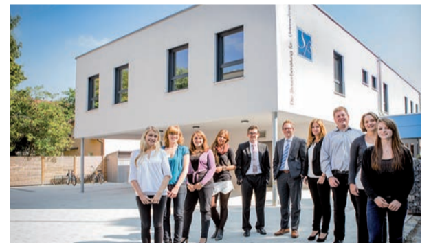
Neubau eines Bürogebäudes in Dachau
